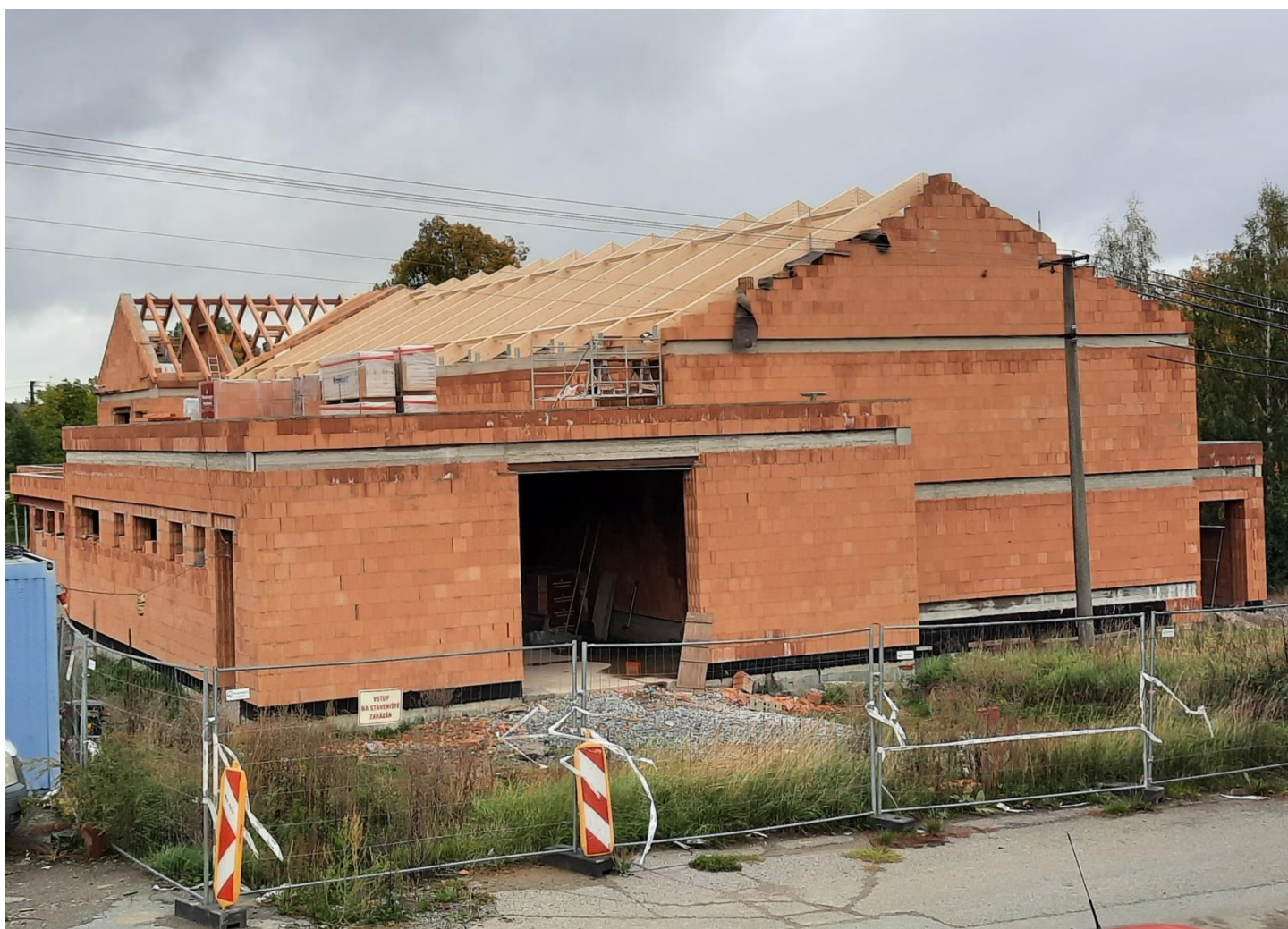
Výstavba nového společenského sálu
