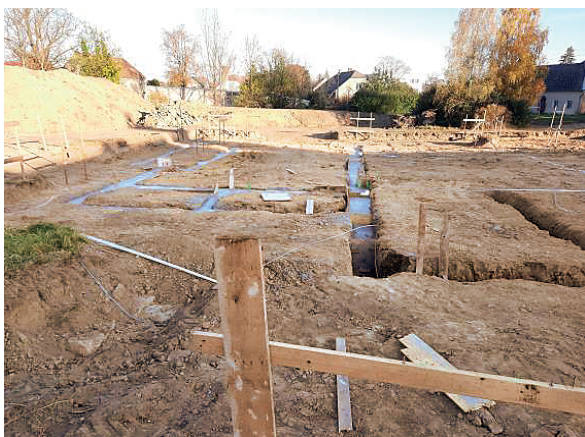
Výstavba nového kulturního sálu
