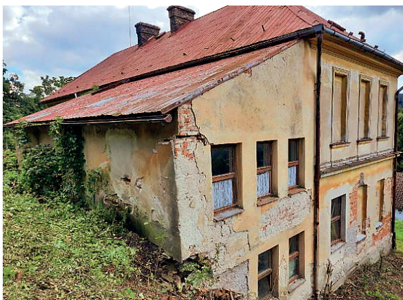
Budova MŠ č.p. 316 před rekonstrukcí
