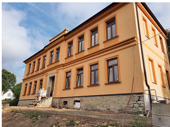
Budova MŠ č.p. 316 po rekonstrukci na 4 byty
