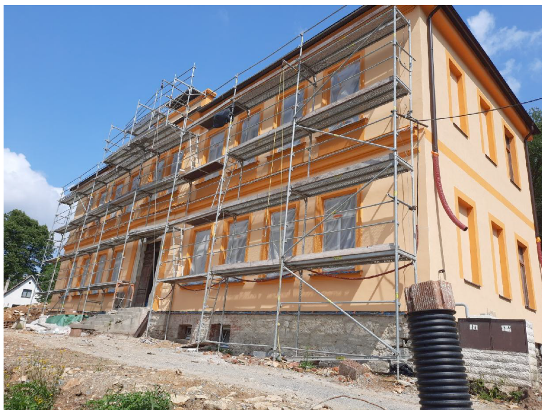
Oprava bývalé horní MŠ na byty finišuje
